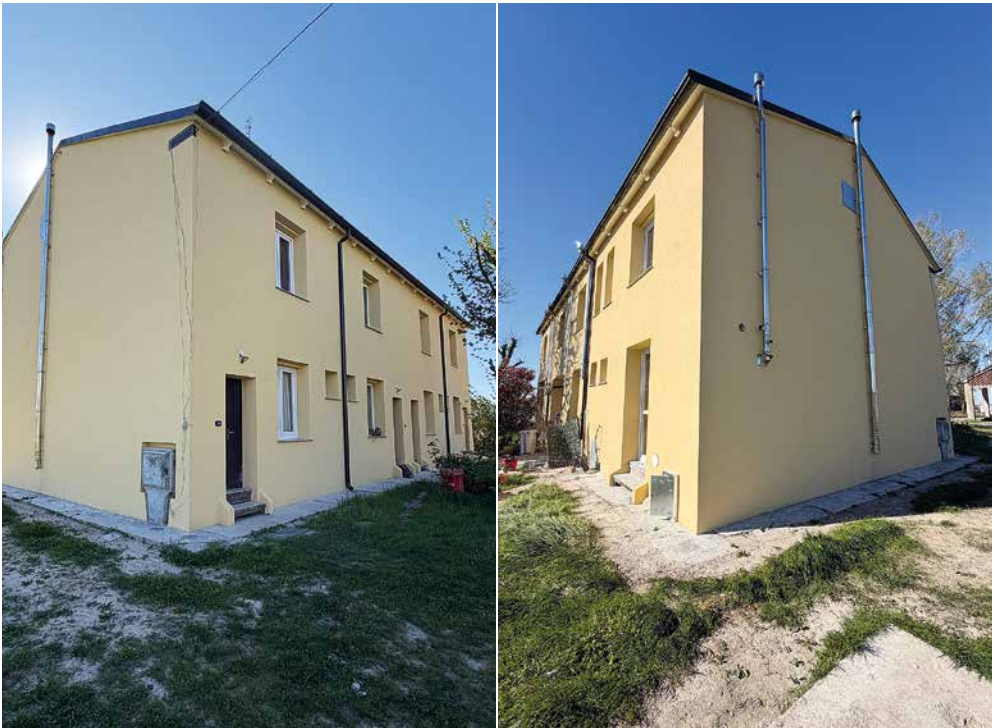
Cascina Cicognola di Binasco dopo i lavori di efficientamento energetico.
